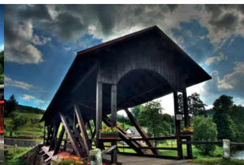
REKONSTRUKCE DŘEVĚNÉHO MOSTU V OBCI SUCHOVRŠICE
